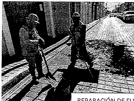
REPARACIÓN DE FUGA
