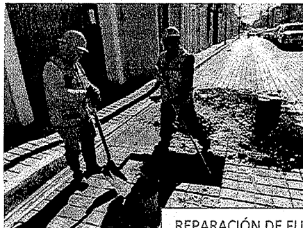
REPARACIÓN DE FUGA
