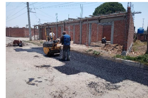
Nota: Fotografía en calle cholula entre 5 de mayo y calle porfirio días en localidad San Sebastian Tepalcatepec en tendido y compactación de carpeta asfáltica.
