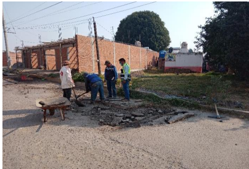
Nota: Fotografía en calle cholula entre 5 de mayo y calle porfirio días en localidad San Sebastian Tepalcatepec en retiro de carpeta asfáltica dañada.
