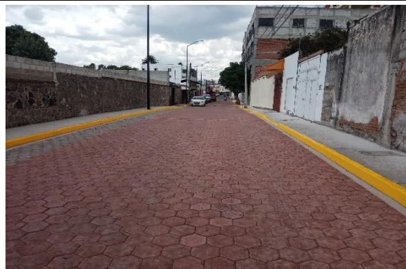
APLICACIÓN DE PINTURA TIPO TRAFICO EN GUARNICIONES
