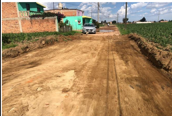
EXCAVACIÓN EN CAJA Y RETIRO DE MATERIAL PRODUCTO DE EXCAVACIÓN
