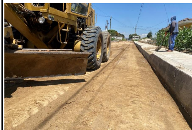
AFINE DE CAPA SUBRASANTE CON EQUIPO MECANICO
