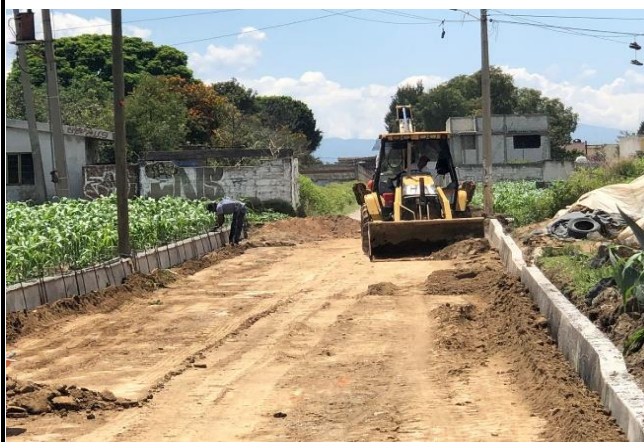
CIMBRADO Y COLADO DE GUARNICIONES CON CONCRETO DE RESISTENCIA F´C=150 KG/CM2
