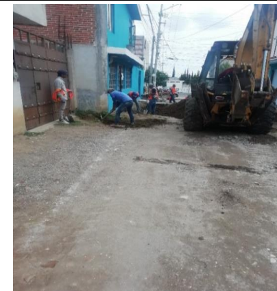
EXCAVACIÓN EN CAJA POR MEDIOS MECANICOS
