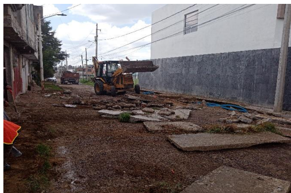
RETIRO DE MATERIAL PRODUCTO DE DEMOLICIÓN
