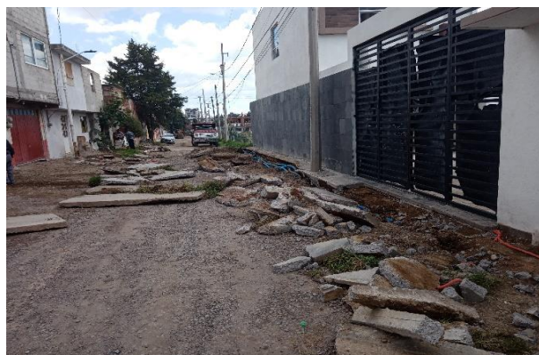
DEMOLICIÓN DE BANQUETAS Y GUARNICIONES EXISTENTES
