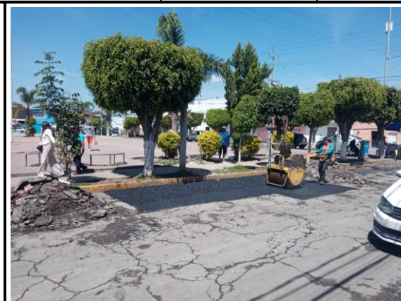
TENDIDO Y COMPACTACIÓN DE CARPETA ASFÁLTICA
