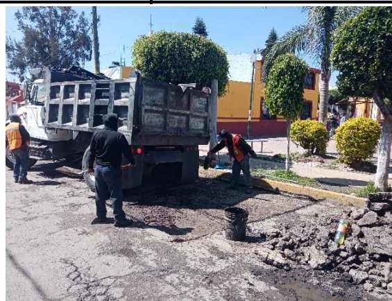
APLICACIÓN DE RIEGO DE LIGA
