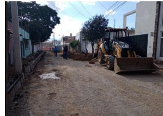
EXCAVACIÓN DE ZANJA PARA GUARNICIONES
